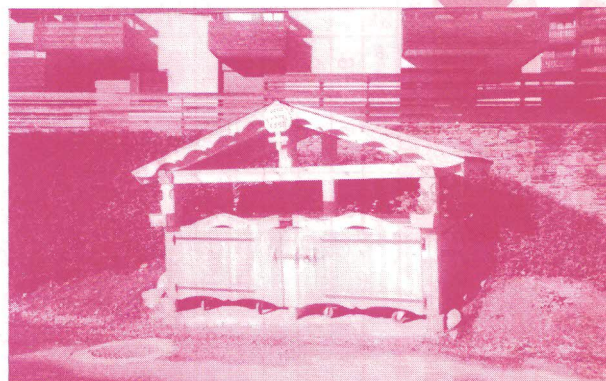
Un bel exemple d'abri-poubelle... à généraliser
